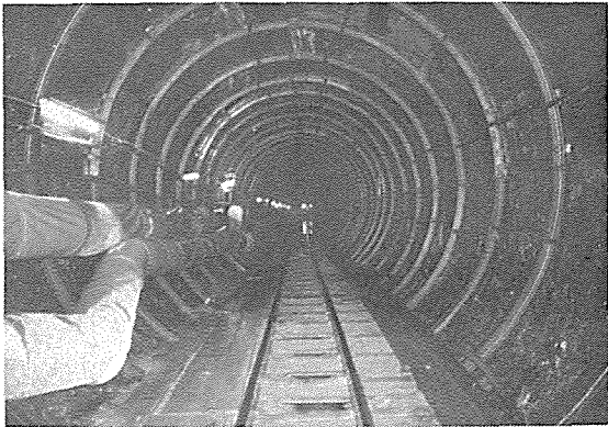
写真－６ 坑内状況
