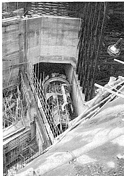
写真-2 組立状況
