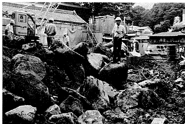
写真-5 掘削された転石
