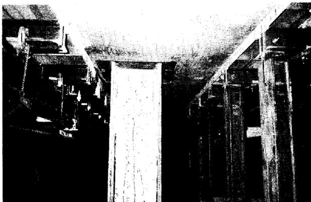
写真-3 中間杭部バラ型枠解体完了
