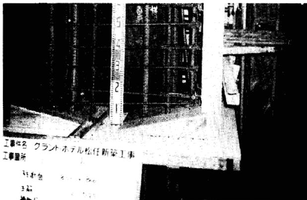
写真-2 柱型枠建込状況
