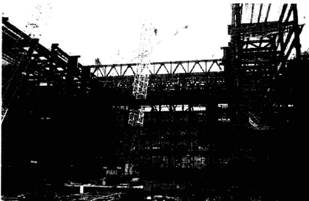
写真-3 トラス梁の取付け
