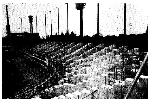
写真-1 PCa大梁架設状況
