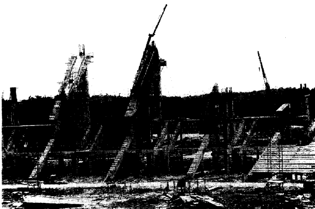
写真-2 斜め梁型枠状況
