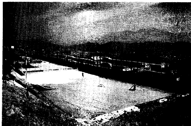
写真-3 打設状況
