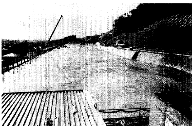
写真-4 軽量盛土完了
