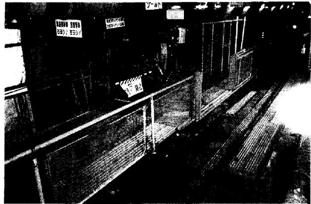
写真-6 分岐用坑内搬送用ターンテーブル
