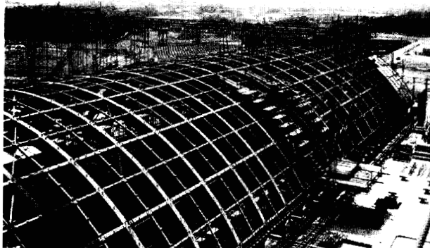
写真-3 門型クレーン移動足場
