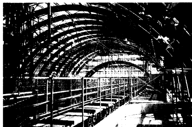
写真-4 枠組み足場上レール敷設状況
