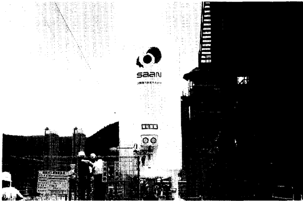
写真-1 液体窒素貯蔵設備
