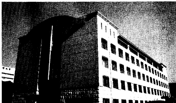
写真－1 建物全景
