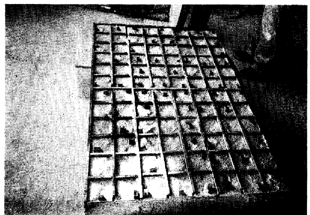
写真-4 第2案 パック除去前のタイル面
