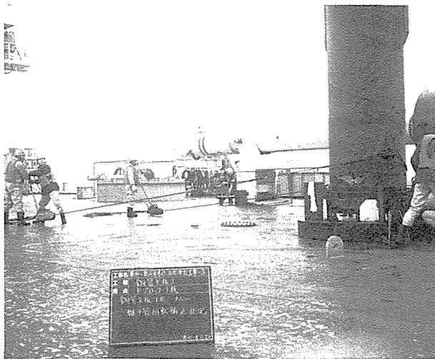
写真-3 継手方向調整作業状況
