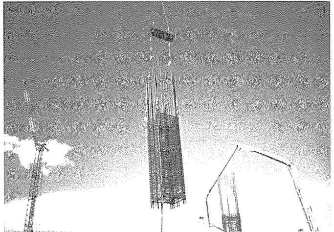
写真-5 先組みした柱筋の建込み状況
