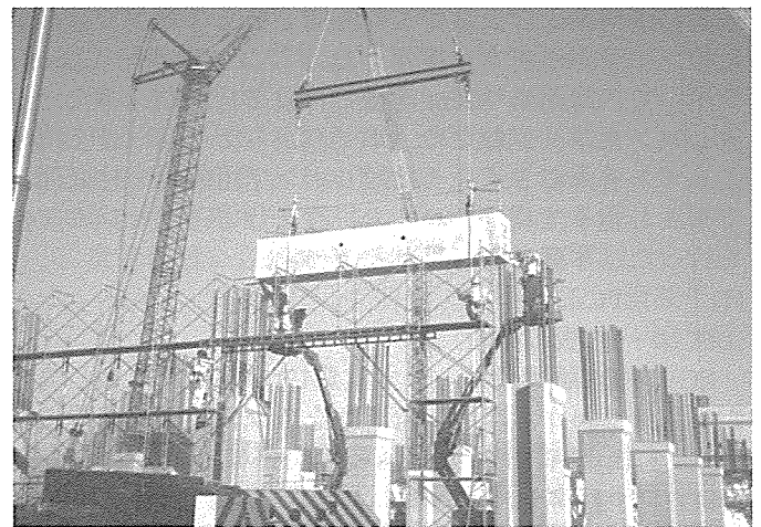
写真-9 PC梁の架設状況
