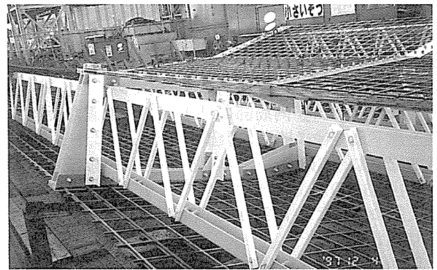
写真-1 格子状CFRPと補強枠
