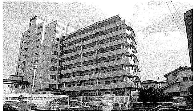
写真-4 大和住宅（7階で実験を行った）
