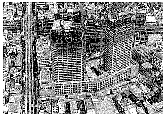
写真-2 ネオフォームの取付状況全景
