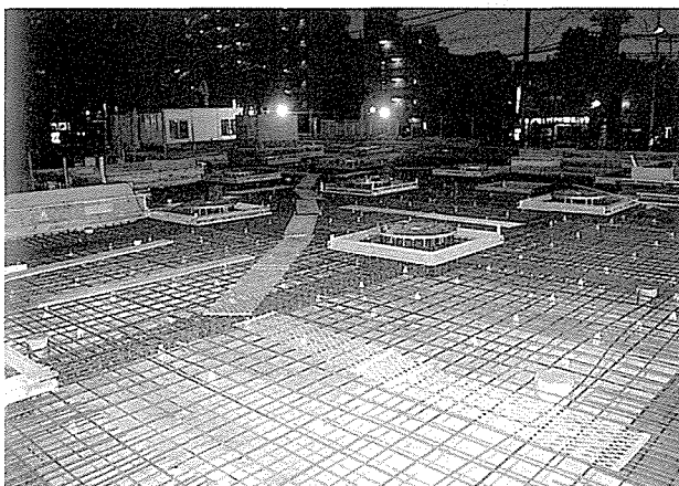
写真-7 免震基礎下部打設前
