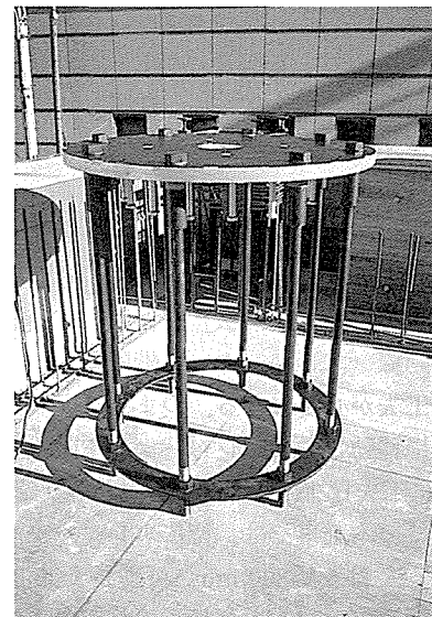
写真－5 免震アンカーベースプレート
