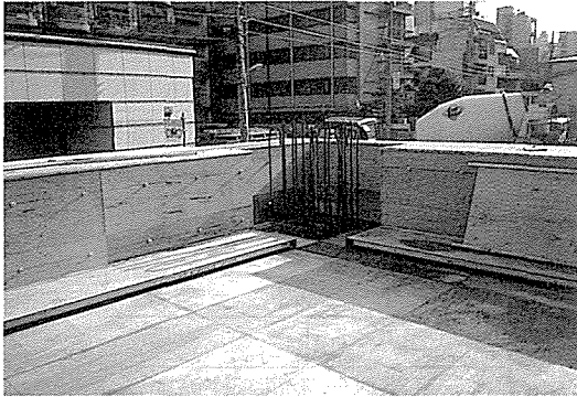
写真－1 仮スラブ型枠貼
