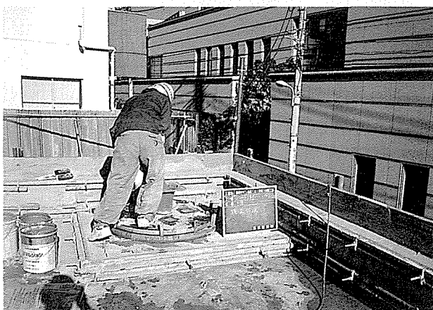
写真-8 グラウト注入
