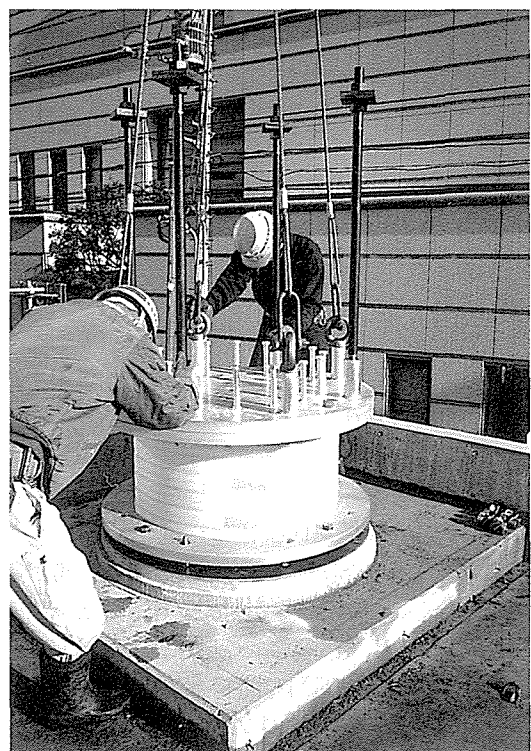
写真-11 免震装置セット
