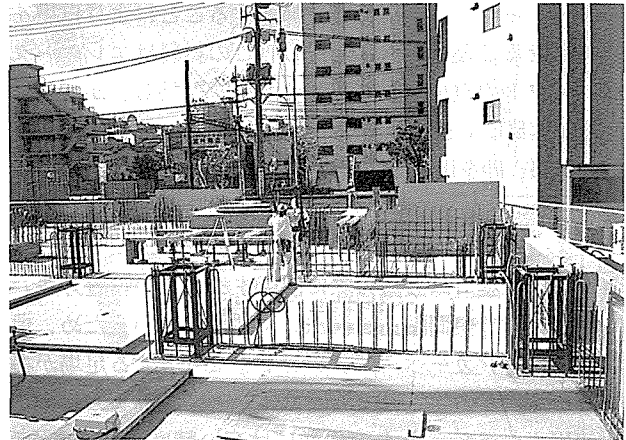
写真－4 免震架台セット2
