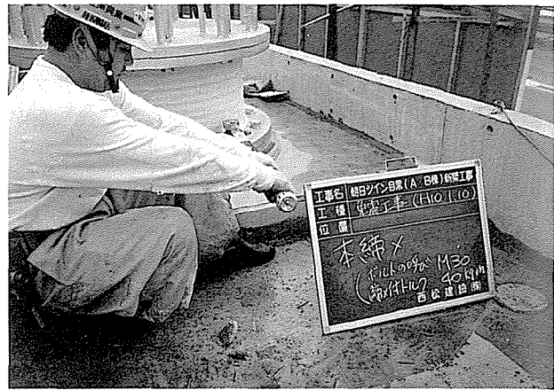
写真-12 トルク締め付け検査
