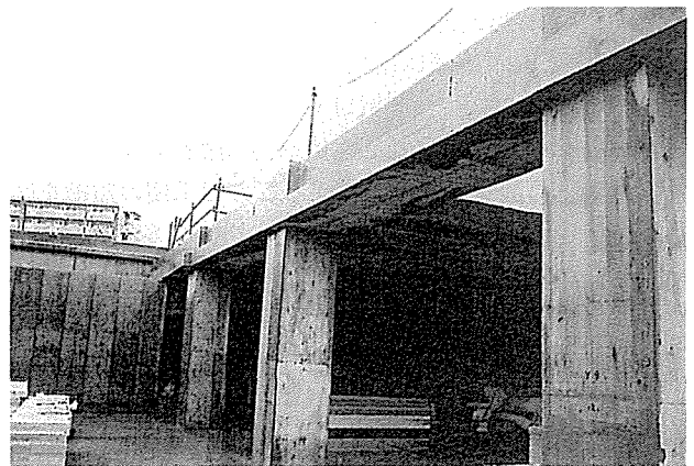
写真-2 PC受梁 (R階)
