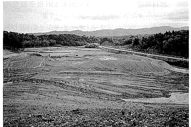
写真-1 着工前盛土状況
