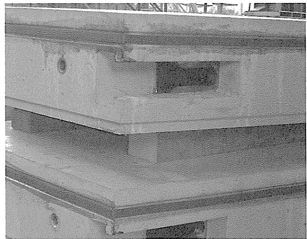
写真-13 Kセグメント切り欠け部構造
