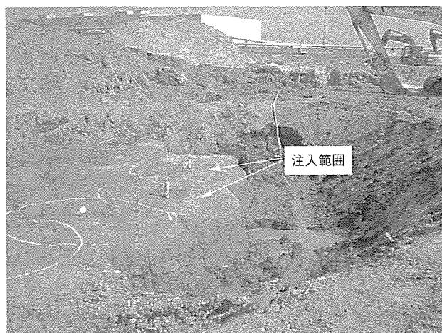
写真-6 注入固化体の試掘状況
