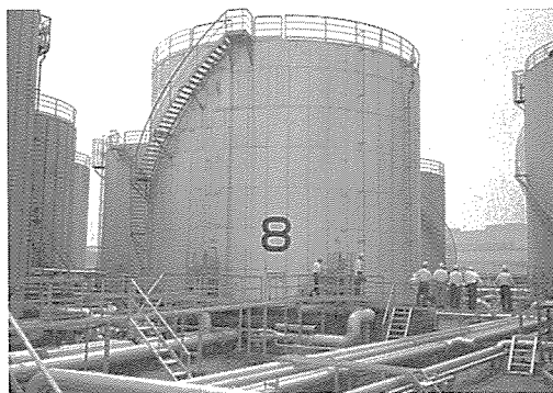
写真-4 実験対象タンク
