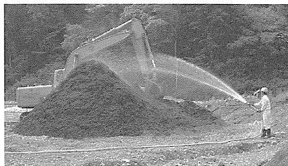
写真-2 仕込み（散水）
