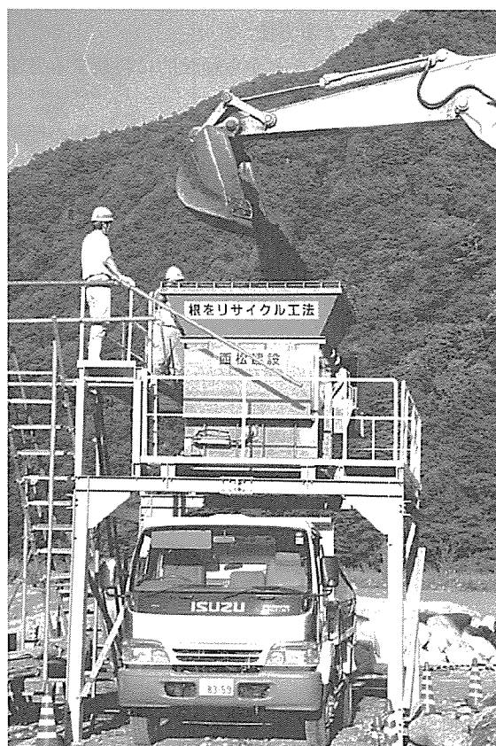
写真－4 2軸ミキサによる混合
