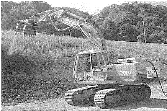
写真-6 のり面への吹付け
