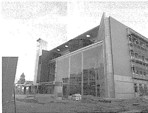
写真-1 WCW1・2完成写真
