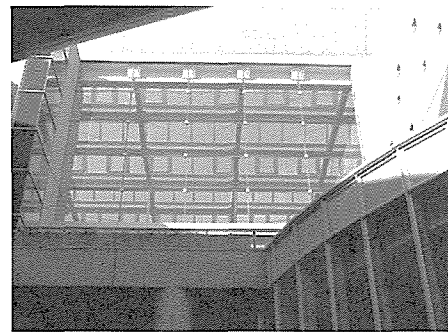
写真-2 WCW3完成写真
