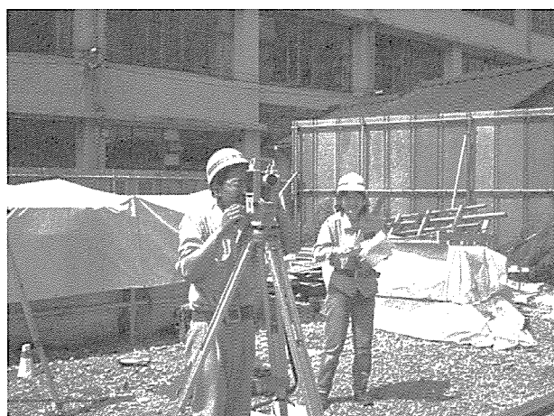
写真-4 トランシットによる端部変形量確認
