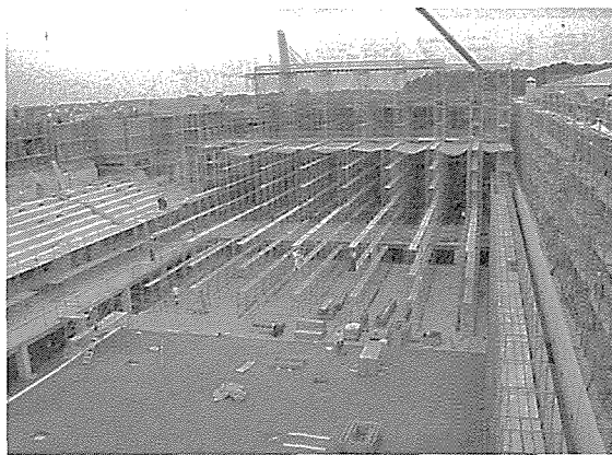
写真-1 全面足場組立状況
