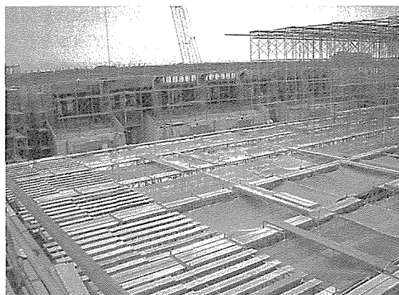
写真-2 作業床状況
