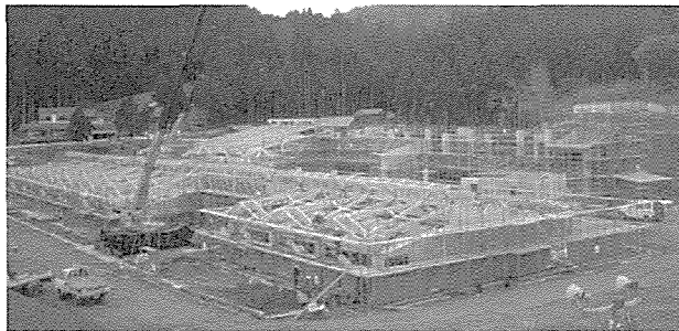
写真-1 施工現場全景
