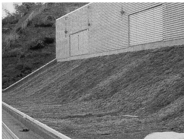
写真-3 時津町文化会館屋上緑化
