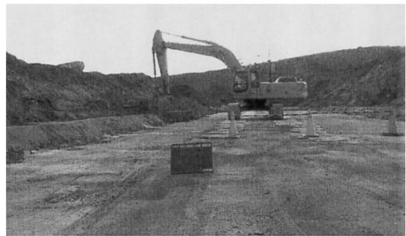
写真-1 土砂型枠設置状況
