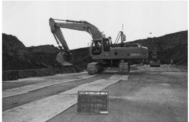
写真-6 ベルコンマットによる打設面養生状況
