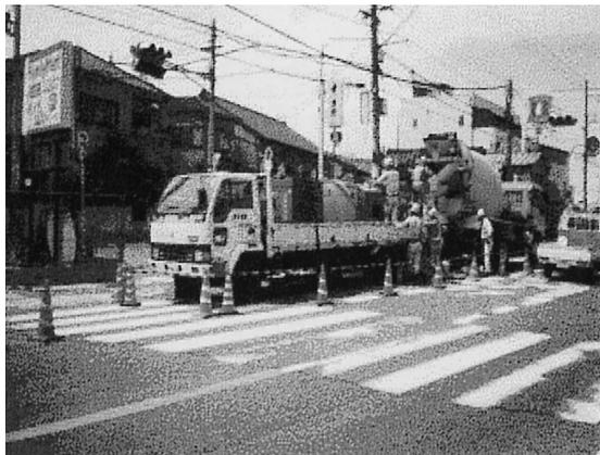
写真-2 コンクリート打設状況 (地上)
