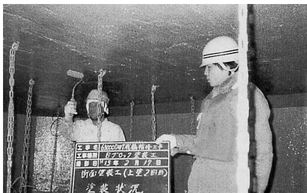
写真-4 上塗り工
