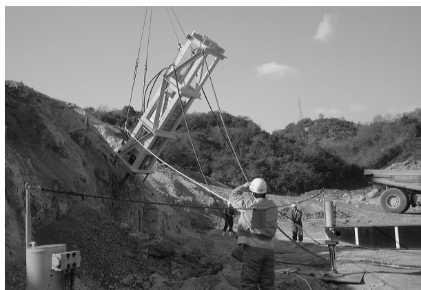
写真-1 掘削状況（気中試験施工）
