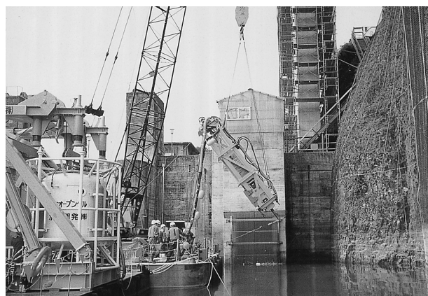
写真-2 掘削状況（実施工）
