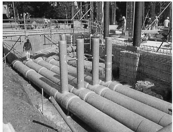
写真-1 クールチューブ VP600A 布設状況
