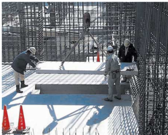
写真-7 UCAS 床版の設置状況
