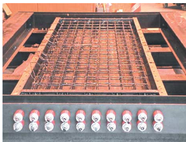
写真-6 配筋状況
