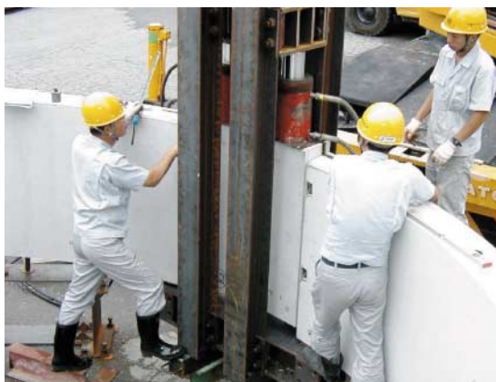
写真-6 水平組立試験状況
