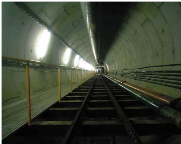
写真-12 セグメント全景
