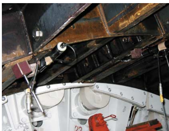
写真-9 現場仮組試験状況
