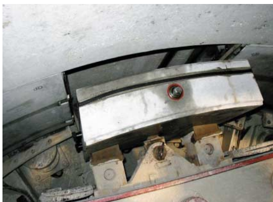
写真-11 Kセグメント組立状況
