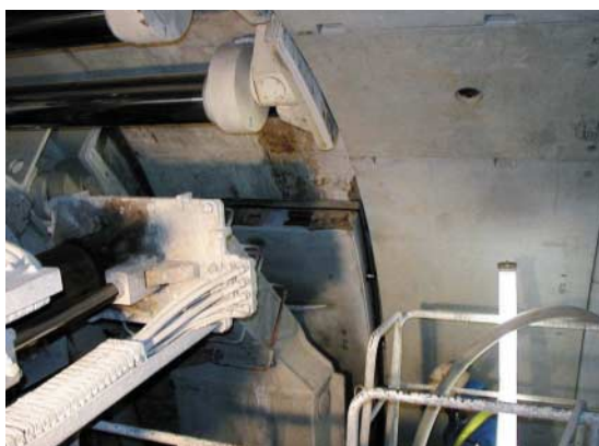
写真-10 Aセグメント組立状況
