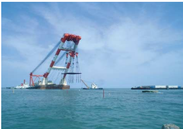
写真-8 台船からの函体吊り込み
