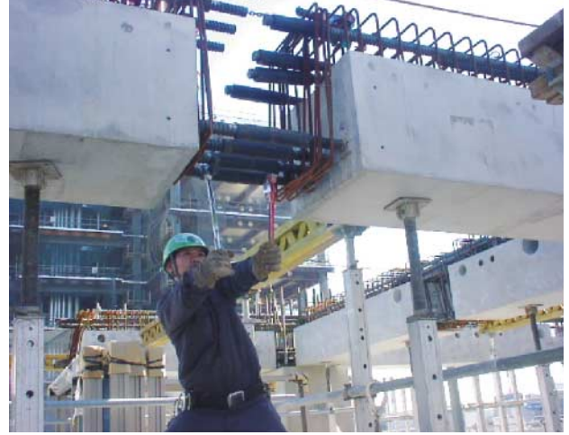
写真-2 梁 PCa（機械式継ぎ手）
