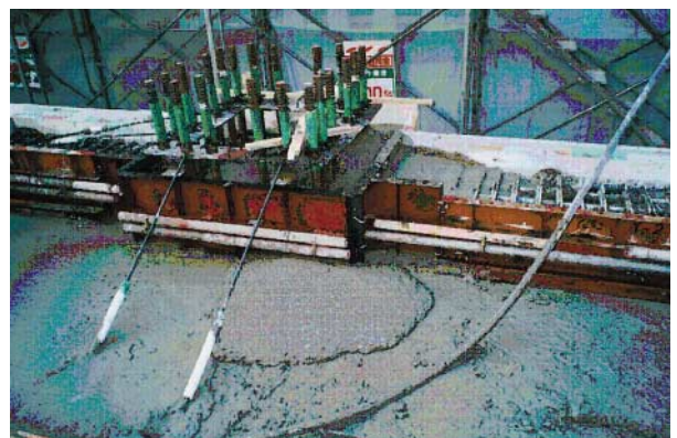
写真-4 逆梁のコンクリート打設
