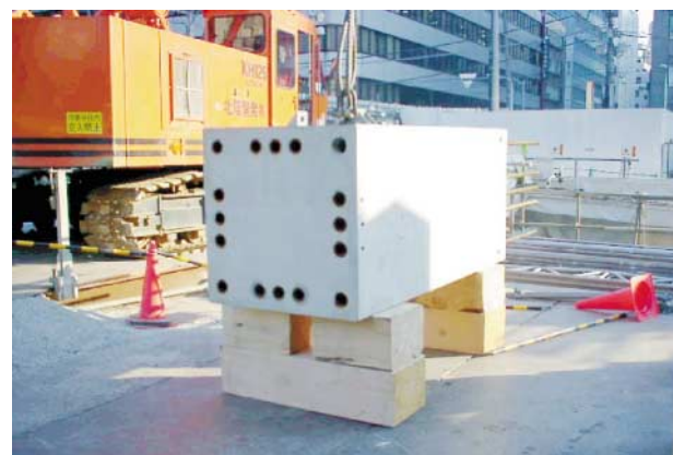
写真-1 柱 PCa (スリーブ継ぎ手)
