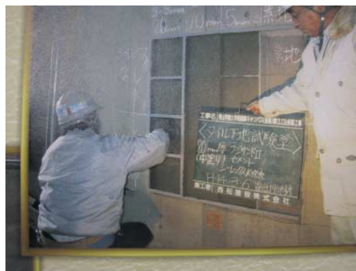
写真-6 モルタル塗り接着試験状況
