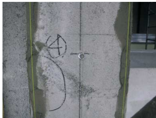
写真-7 柱コーナー部の施工状況
