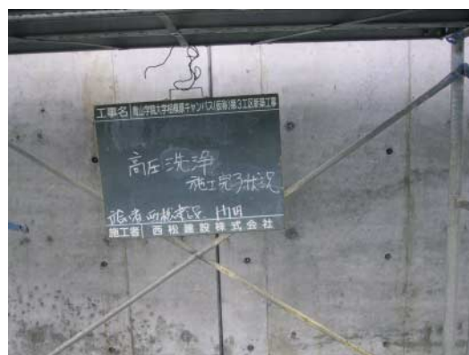
写真-5 高圧洗浄完了状況
