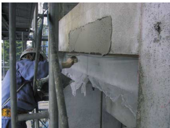
写真-9 梁部分の施工状況
