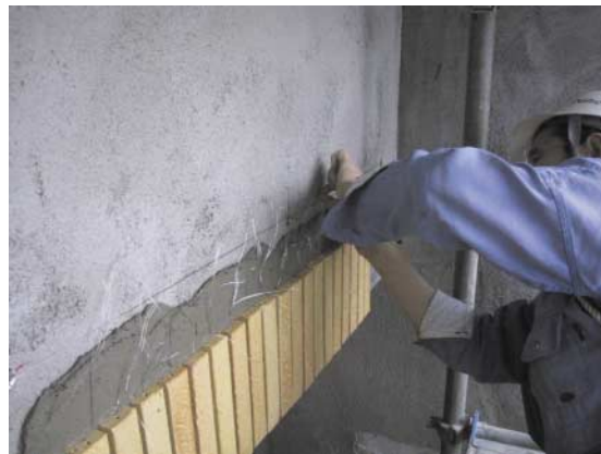
写真-10 梁出隅タイル施工状況
