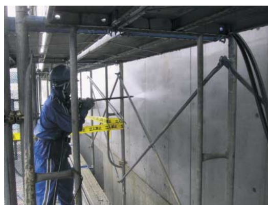
写真-4 実躯体における高圧洗浄試験状況
