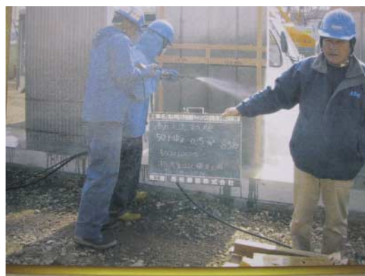
写真-2 目荒し工法の現場試験状況
