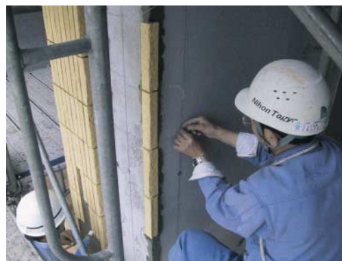
写真-8 柱コーナー部の施工状況
