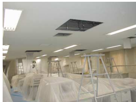
(a) 事務所内改修状況
