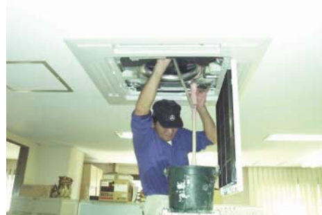
(b) 空調ドレン配管通水テスト状況
