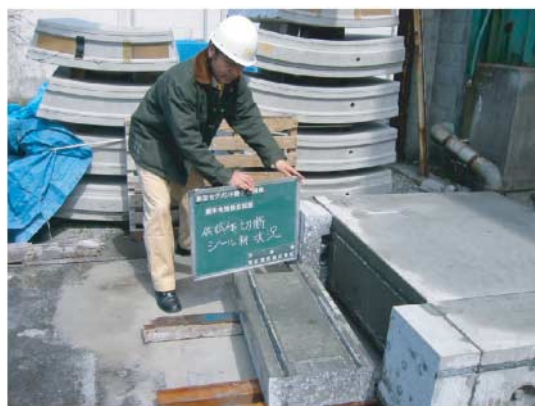
図-15 組立後のシール材確認状況
