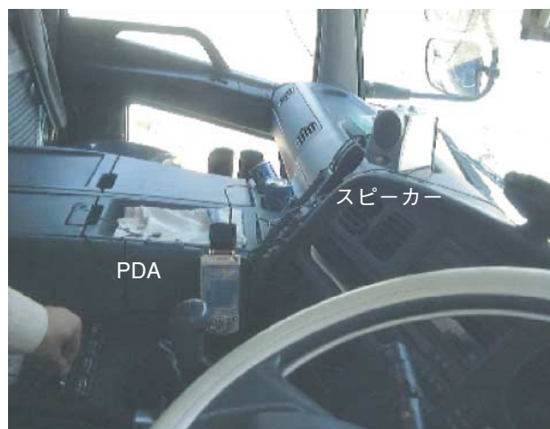
写真-4 工事用車両へのシステム設置例
