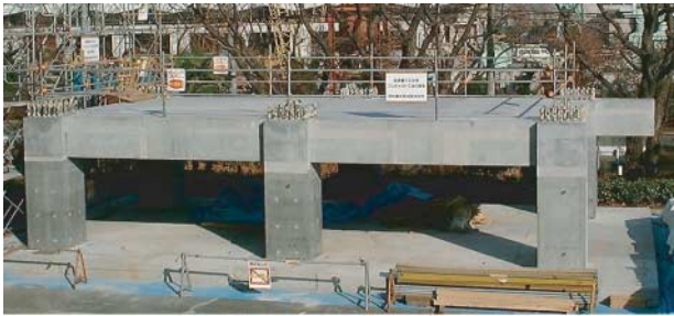
写真-1 施工実験の状況
