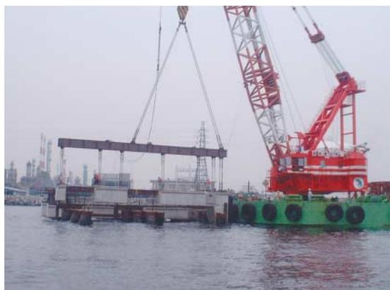
写真-4 梁スラブタイププレキャスト梁据え付け状況
