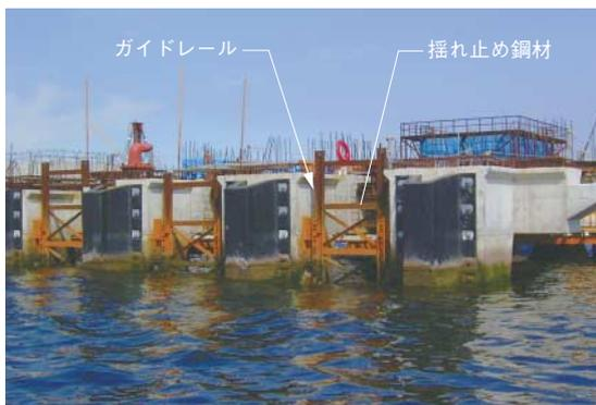
写真-5 重油棧橋プレキャスト大梁結構状況
