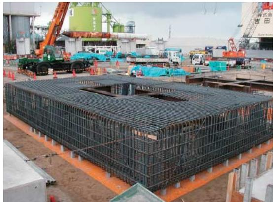
写真-2 プレキャスト部材鉄筋組上がり状況
