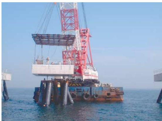
写真-3 フラットスラブタイプ PC 部材据え付け状況
