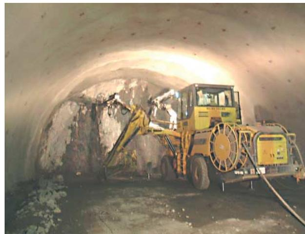
写真-1 全自動コンピュータージャンボの削孔状況
