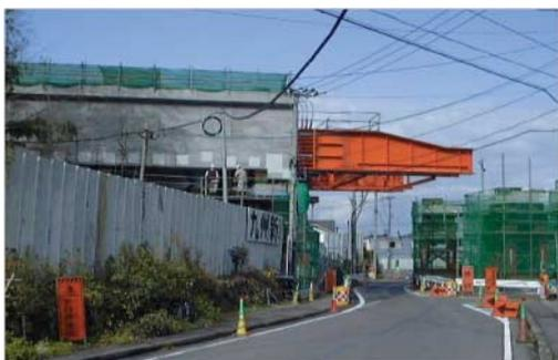
写真-2 短手延べ桁による押し出し状況
