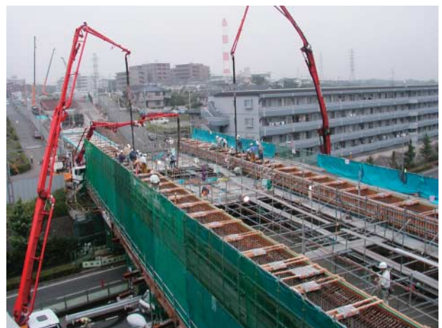
写真-5 コンクリートの打設方法
