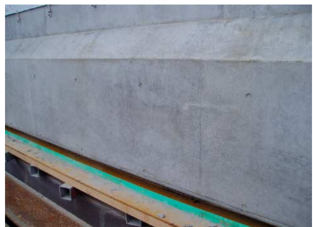
写真-8 定着部仕上げ後
