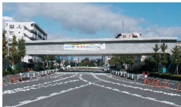
写真-1 PC 下路桁全景
