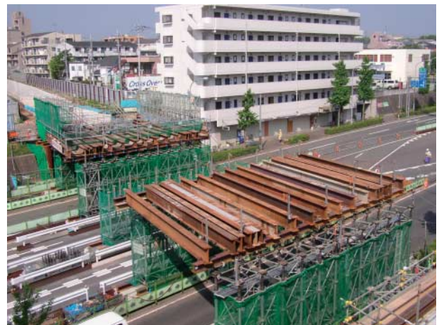
写真-3 支保工架設状況
