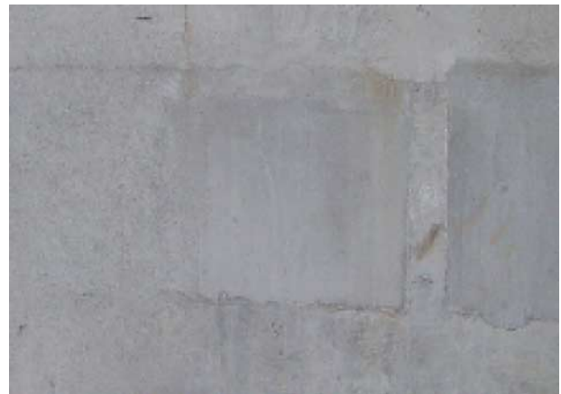
写真-7 定着部仕上げ前
