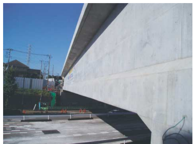
写真-9 定着部仕上げ後全景
