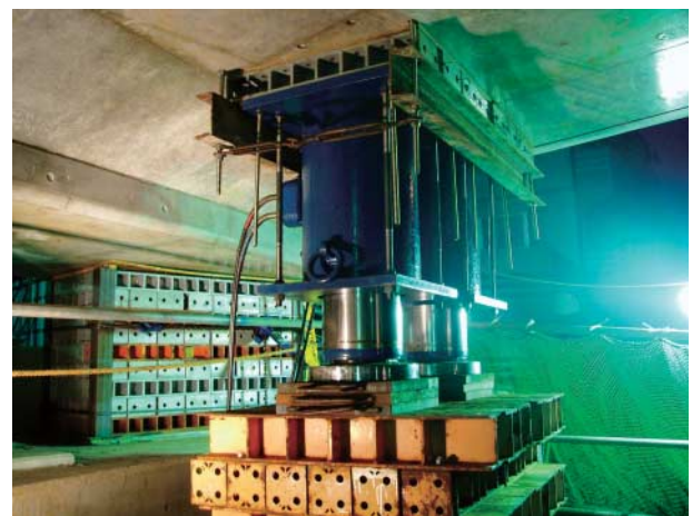
写真-6 油圧ジャッキ配置状況
