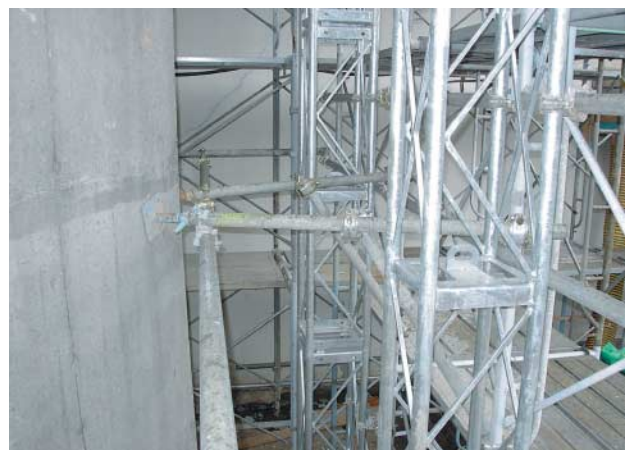
図-5 専用マストと壁あて（左側が煙突躯体）
