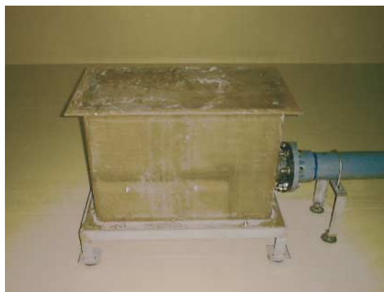
写真-2 ディストリビュータ設置部分
