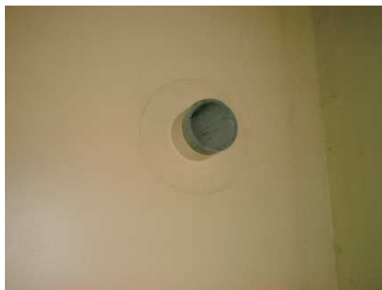
写真-1 連通口設置状況
