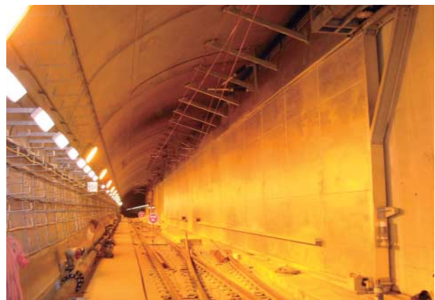
写真-2 完成したスライド式防火扉
