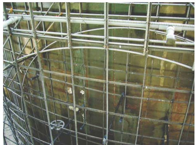
写真-1 鏡切部のコンポーズ配筋状況
