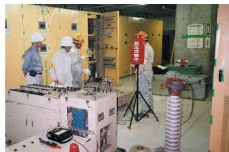
写真-3 受変電設備自主検査
